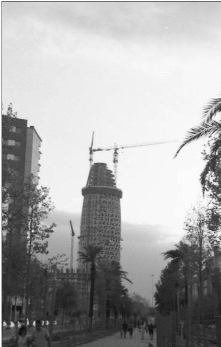
Torre Agbar en obres (Contra-Infos)
